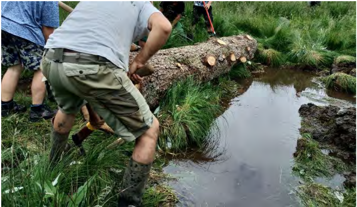
Abb. 2: Einbau eines Baumstammes zur Wasserrückhaltung im Schwemmgebiet des Täli (Aufnahme Juni 2024)
