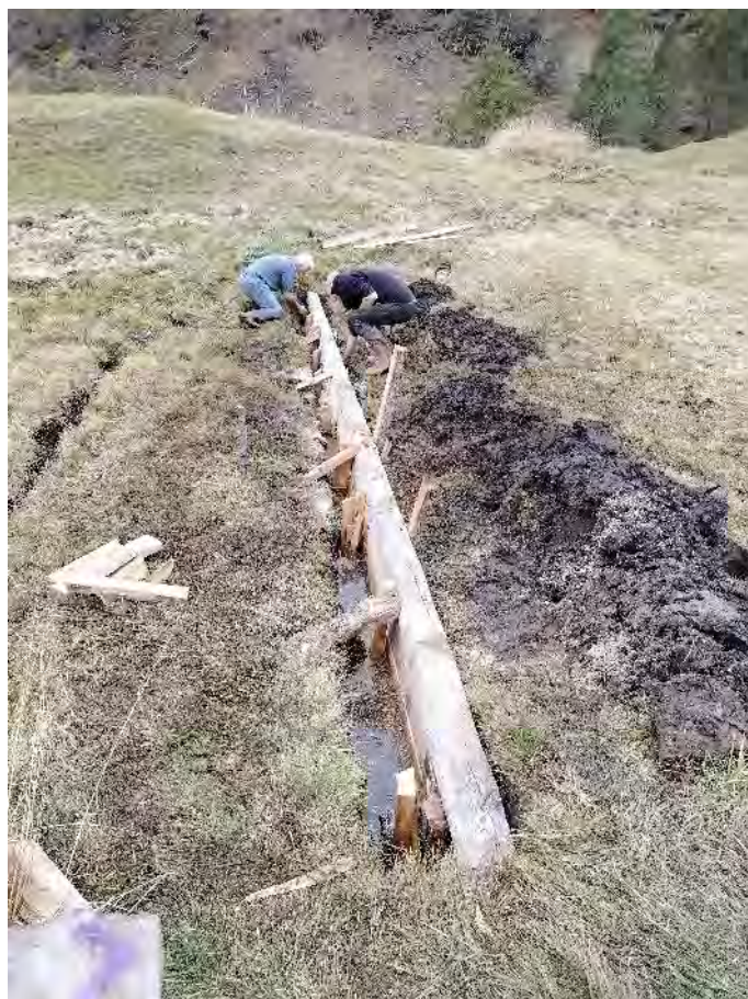
Abb. 5: Einbau des Dammes am unteren Ende des Ried Foppei (Aufnahme Oktober 2024)
