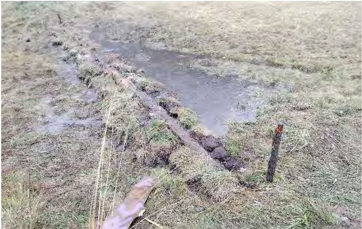
Abb. 6: Wirkung des neu eingebauten Dammes: Wasserrückhaltung im Feuchtgebiet (Aufnahme Oktober 2024).
