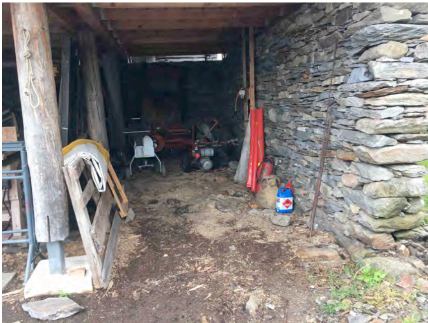
Situation SVELTIN vor dem Betonieren
