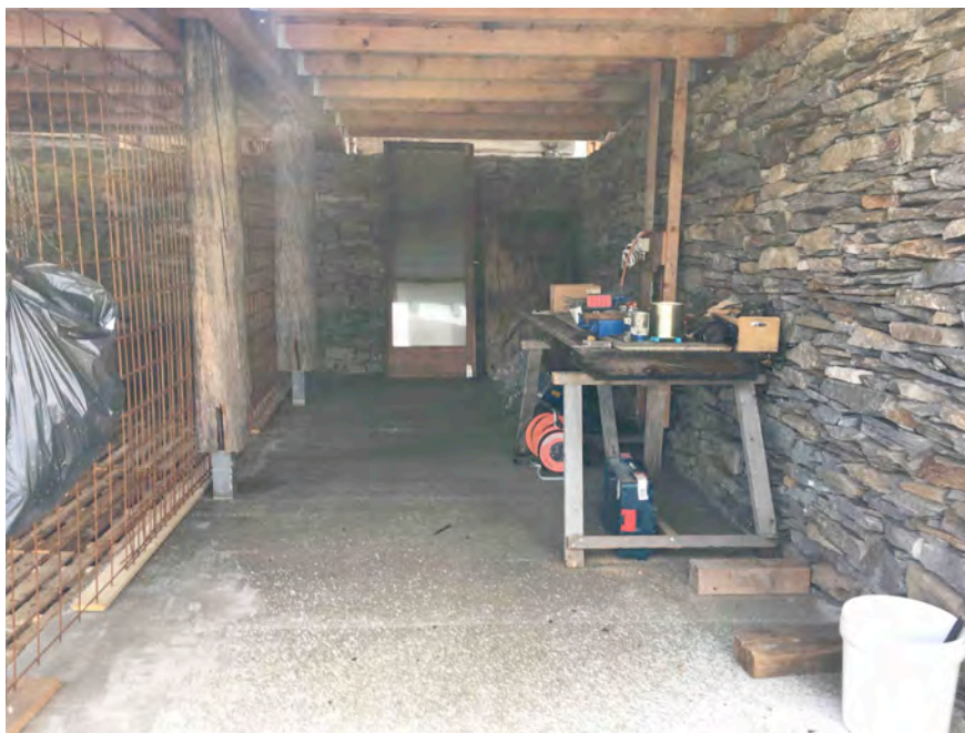
Situation SVELTIN nach dem Betonieren der Bodenplatte
