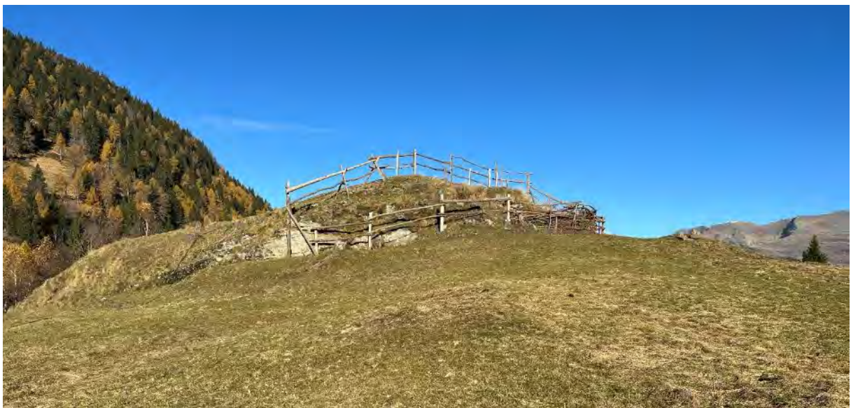
Abb. 4: Der neu gebaute Zaun mit Schutzfunktion für die Gehölzgruppe, Blickrichtung gegen Norden.
