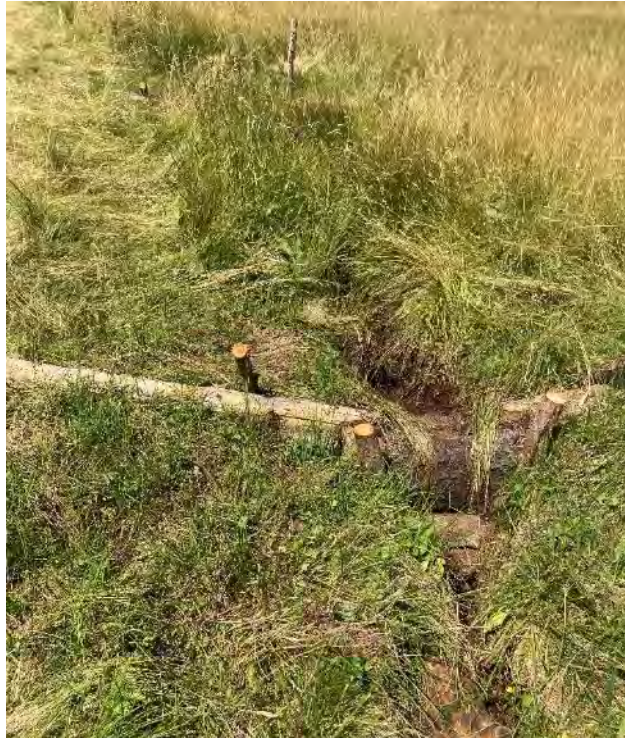
Abb. 12: Eine neu eingebaute Rückhaltstufe
