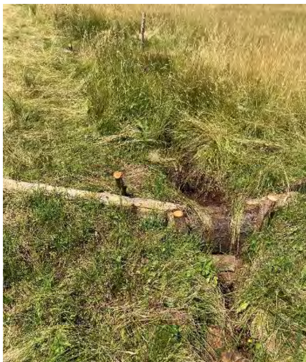
Fig. 12: Un gradino di ritenzione appena installato.
